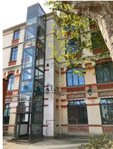
Mise en place d'une cage d'ascenseur pour les personnes à mobilité réduite au collège Manet de Villeneuve-la-Garenne.
