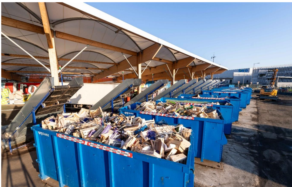
La déchetterie (Point E)
