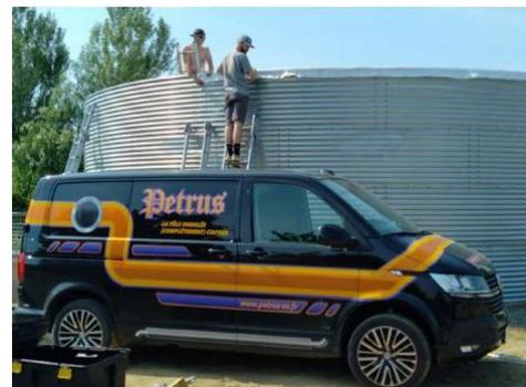
Fort de son savoir-faire en matière de tôle ondulée cintrée, l'entreprise conçoit des réserves d'eau hors sol sur-mesure. D'une capacité de stockage allant de **4 m<sup>3</sup> à 2.500 m<sup>3</sup>**, les **cuves en acier à revêtement métallique** se distinguent par leur résistance et leur facilité d'installation.
