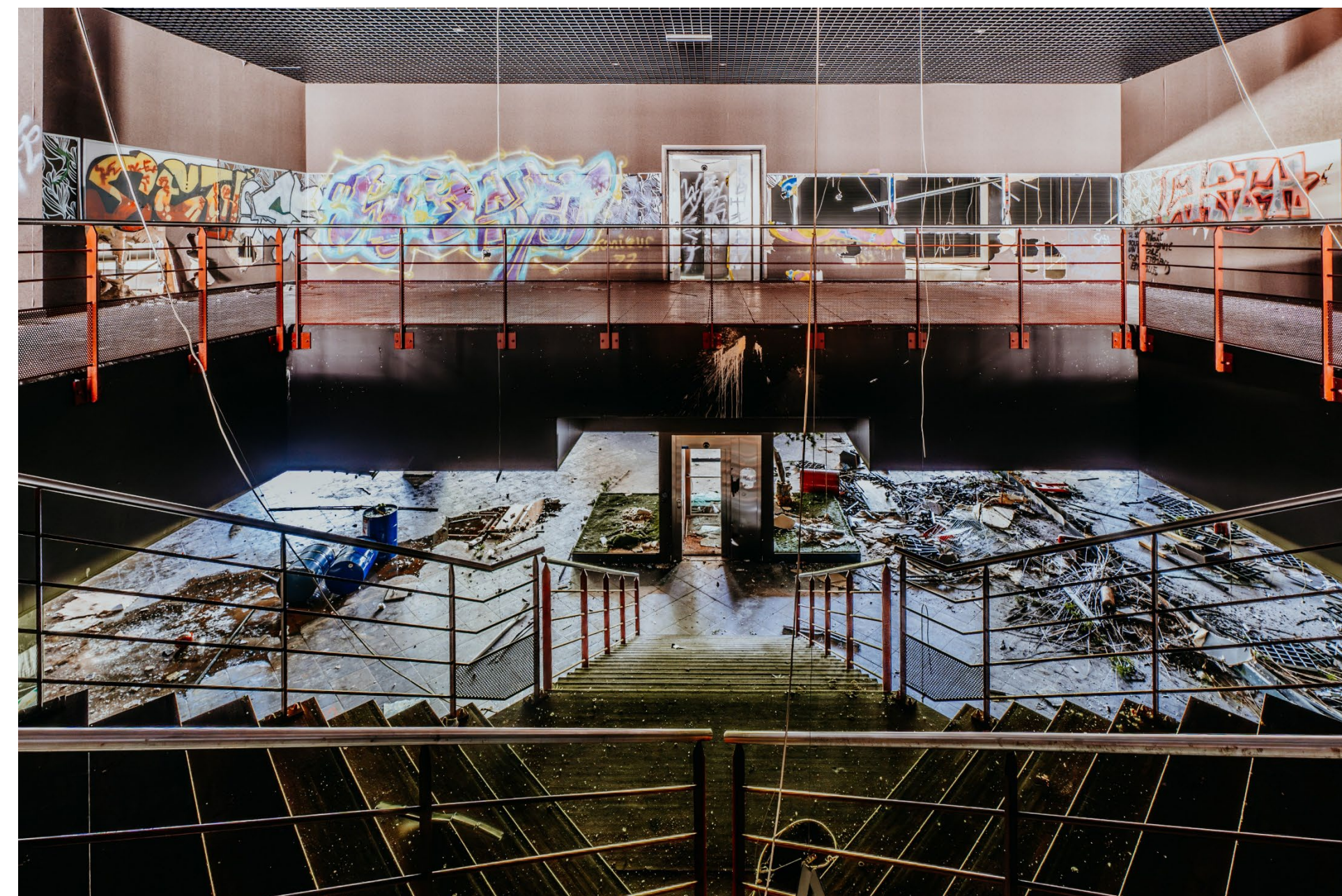
Travaux en cours sur le site de l'ancien Bowling Star
